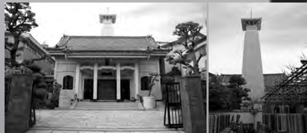
1575年創建、400年以上にわたって寺地を変えていない本久寺。本堂は関東大震災で焼失し、昭和3年に鉄筋コンクリート作りで再建。東京都墨田区東駒形2-21-12
