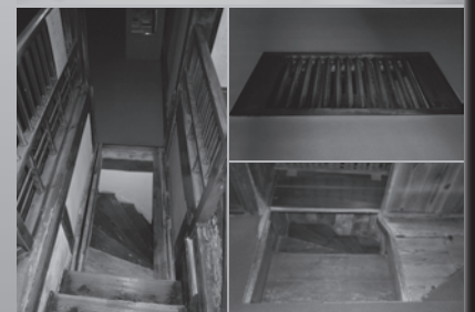
上／城下、南西部「寺町寺院群」にある妙立寺。左下／渡り廊下に見せて、床板を外すと落とし穴になる階段。右中／本堂正面に埋め込まれた寶銭箱には落とし穴にもなる仕掛けが。右下／物置の戸を開き、床板を外すと隠し階段が出現。
